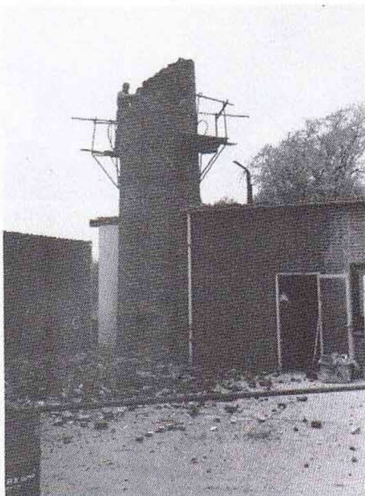
Nedbrydning af skorsten efter lynnedslag.
