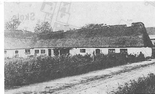
De to kirkefæstekåb bygget sammen i en vinkelbygning.
